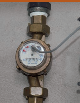
Le compteur à impulsion : il informe la pompe doseuse de la quantité nécessaire de solution d'acide hypochloreux à injecter en fonction du volume d'eau qui passe dans le circuit.
