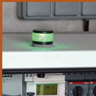
Un voyant vert permet de visualiser le bon fonctionnement de la machine. Lorsque la lumière est orange, la machine est en contrôle lavage ou en régénération. Lorsqu'elle est rouge, elle ne fonctionne pas correctement : manque de sel, température trop basse ou pression du réseau trop faible.
